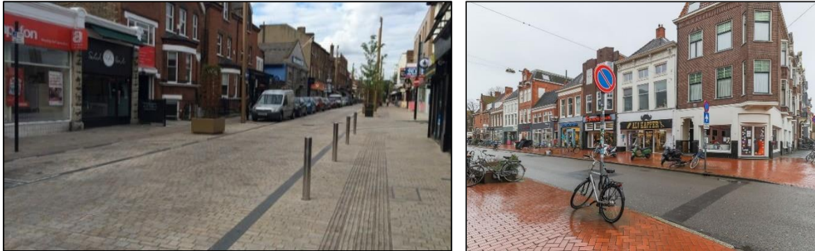
Abbildung 2 Links: kein Kontrast zwischen Fahrbahn und Gehweg. Rechts: starker Kontrast zwischen Fahrbahn und Gehweg
